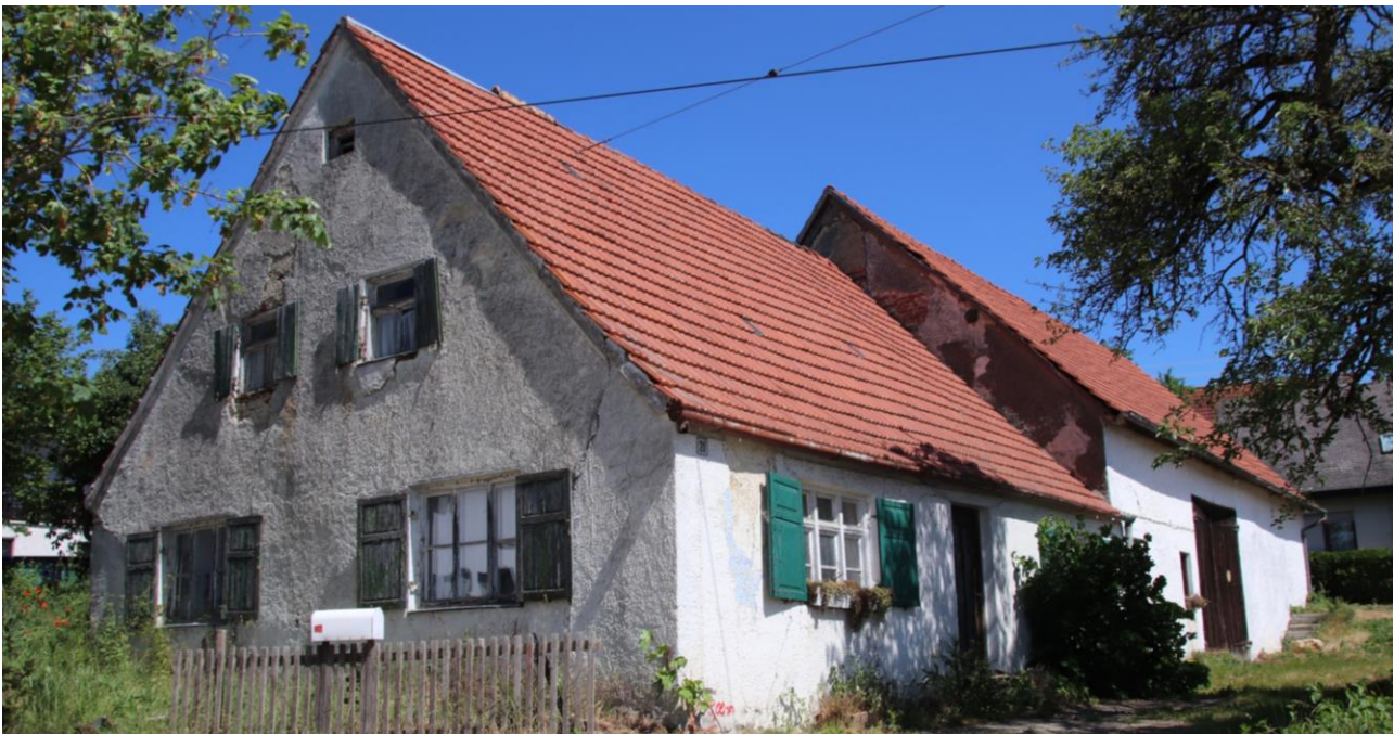
Abbildung 52: Vorherrschende Baustruktur – Bauernhaus, Ortsteil Oberliezheim
