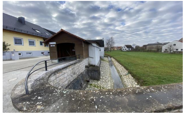
Kanalisierte Bach ohne Zugang, Leiheim
